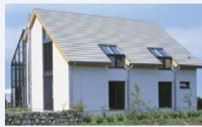
Dachseite für PV Anlage
